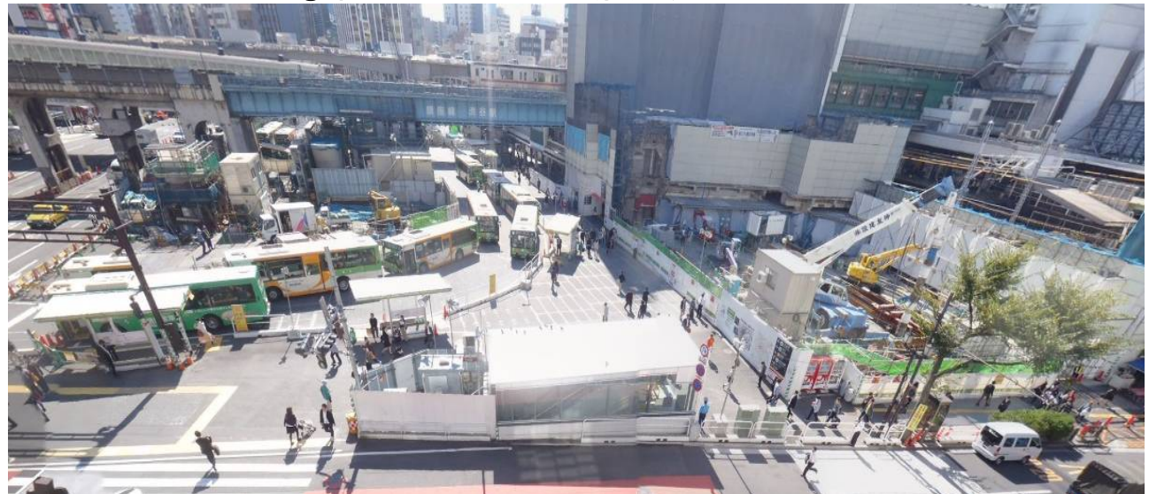
②東口バスロータリー全景(北側 H26.10中旬)
