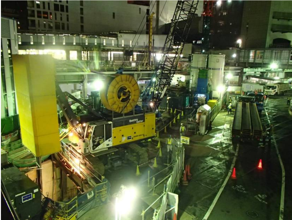
路上施工状況
