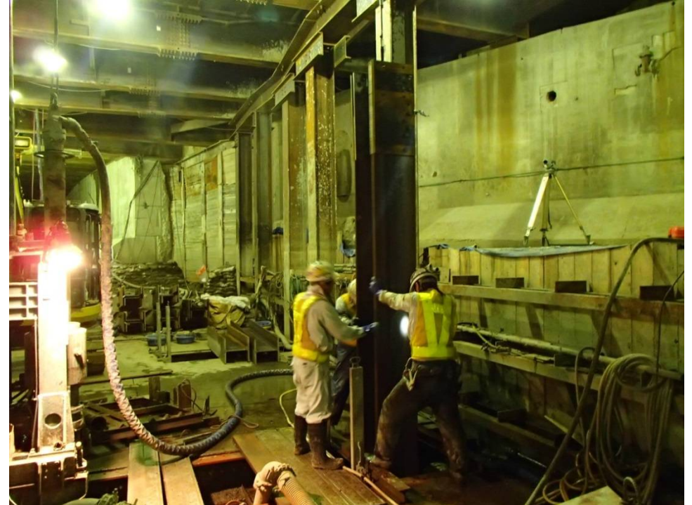
BH杭 芯材建込み
