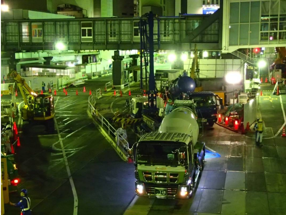
路上施工状況
