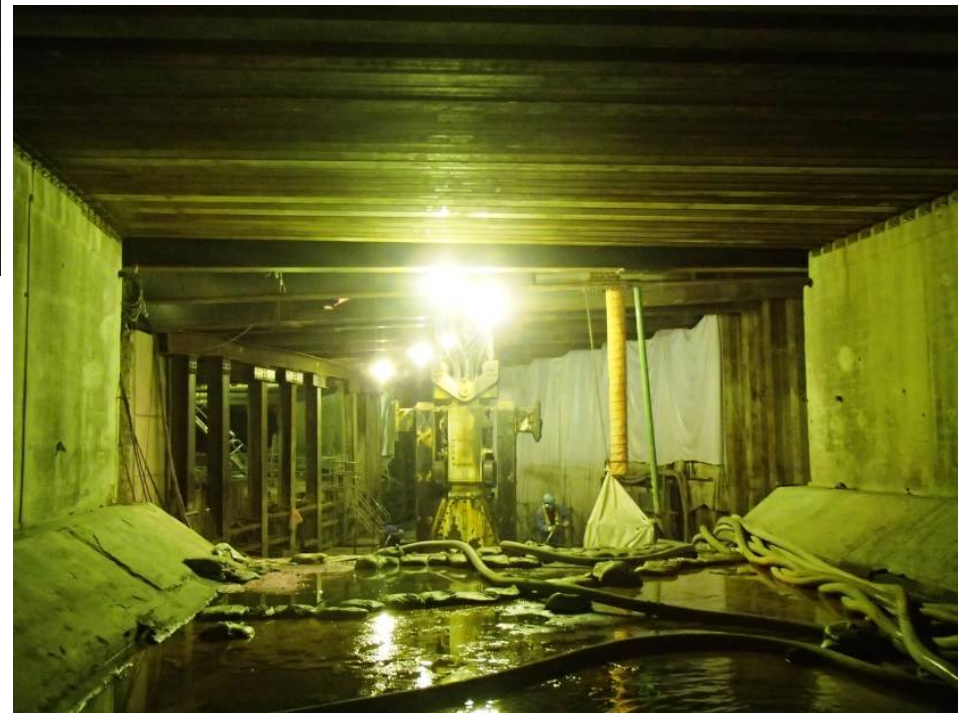
路下施工状況(削孔・造成)
