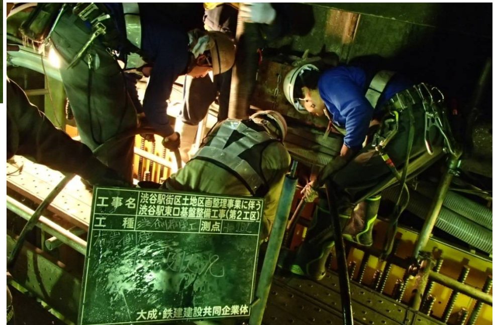
路下施工状況
