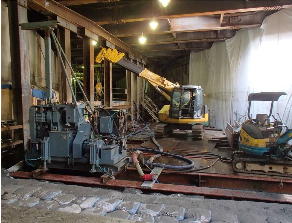
BH杭 削孔状況
