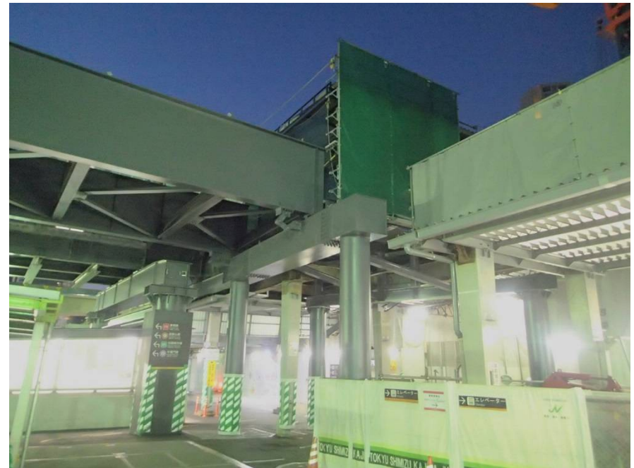
⑨歩行者デッキ架設工事 上屋施工状況(百貨店側)
