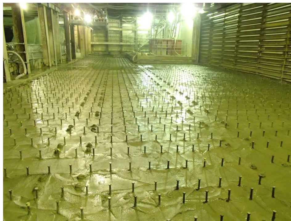
ジベル筋設置完了
