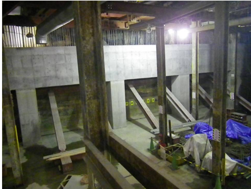
③地下広場(半蔵門線側) 平成27年1月
