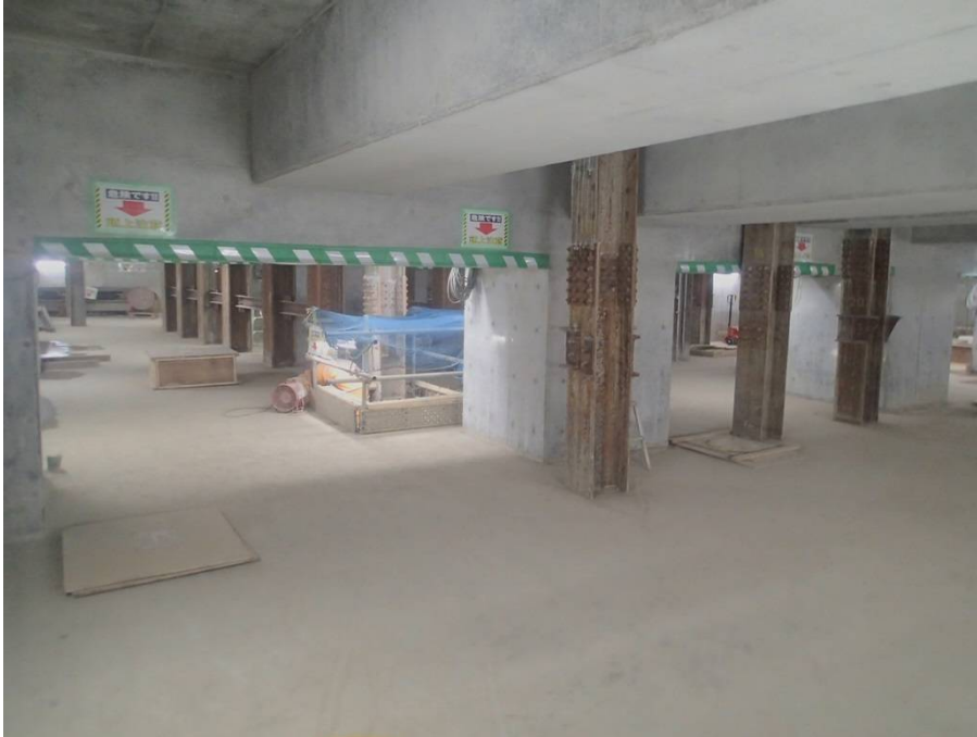
⑤地下貯留槽 躯体構築状況(B3F)
