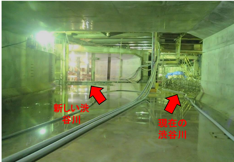
③渋谷川 躯体構築状況(平成27年7月中旬)
