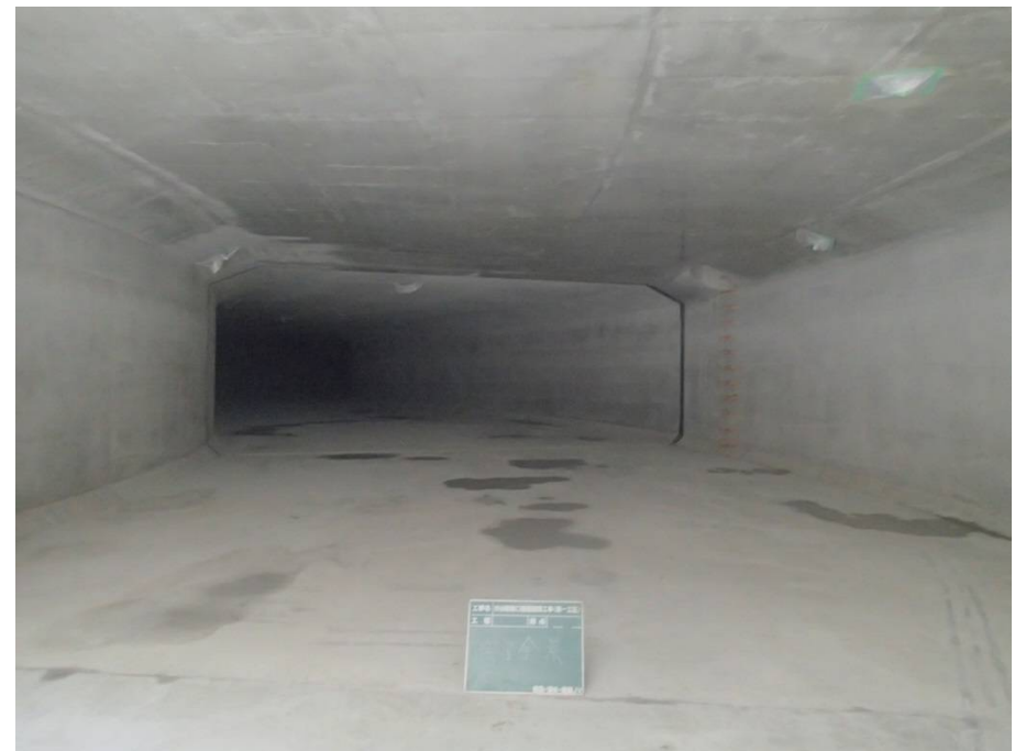
④渋谷川 躯体構築完了(平成27年8月31日)
