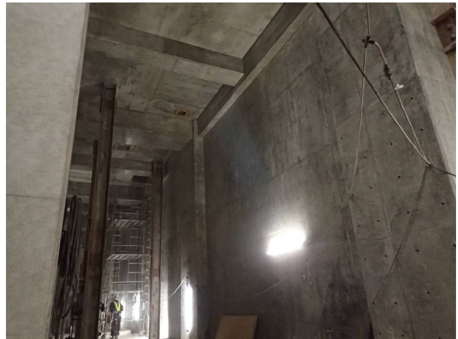
⑥地下貯留槽 躯体構築状況(B4F)
