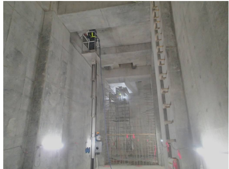
②地下貯留槽 躯体構築状況(B4F)
