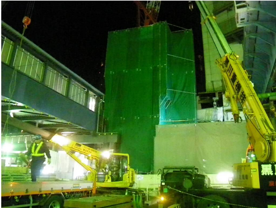
⑤仮設EV 設置状況(1F~2F)
