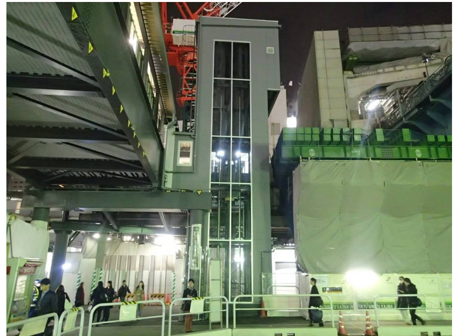
⑥仮設EV 供用開始
